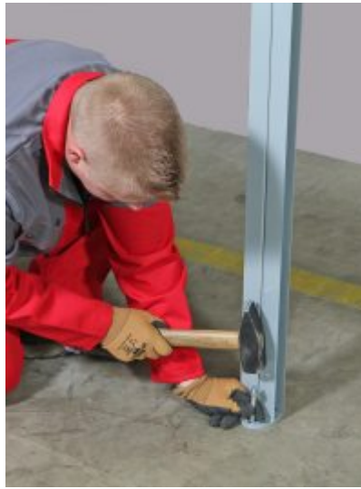
Poraa lattiaan rei'ät runkotolpan kiila-ankkureille ja kiristä kiila-ankkurit
