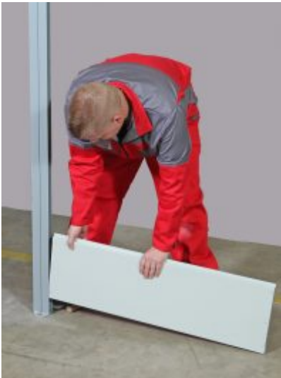
Laita ensimmäinen elementti runkotolpassa olevaan uraan. Asenna seuraava runkotolppa ja elementti paikoilleen.
