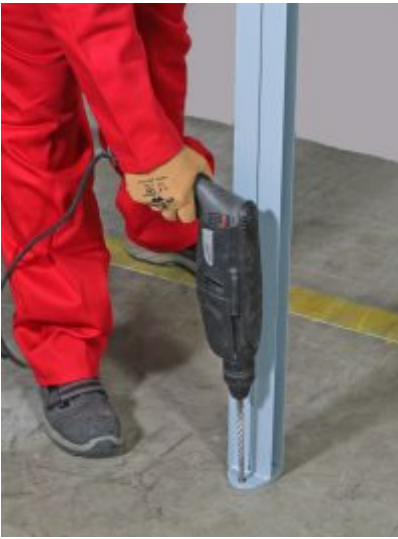
Poraa lattiaan rei'ät runkotolpan kiila-ankkureille ja kiristä kiila-ankkurit
