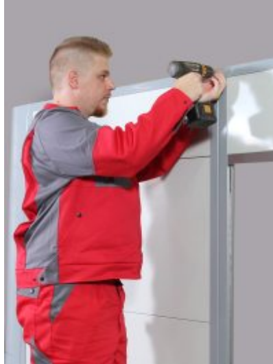
Laita ensimmäinen elementti runkotolpassa olevaan uraan. Asenna seuraava runkotolppa ja elementti paikoilleen.
