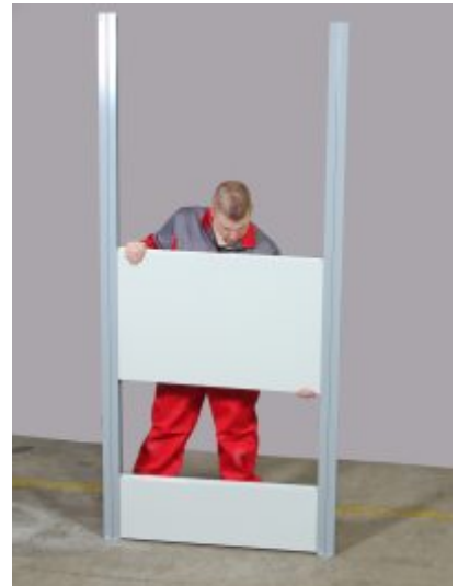
Laita ensimmäinen elementti runkotolpassa olevaan uraan. Asenna seuraava runkotolppa ja elementti paikoilleen.
